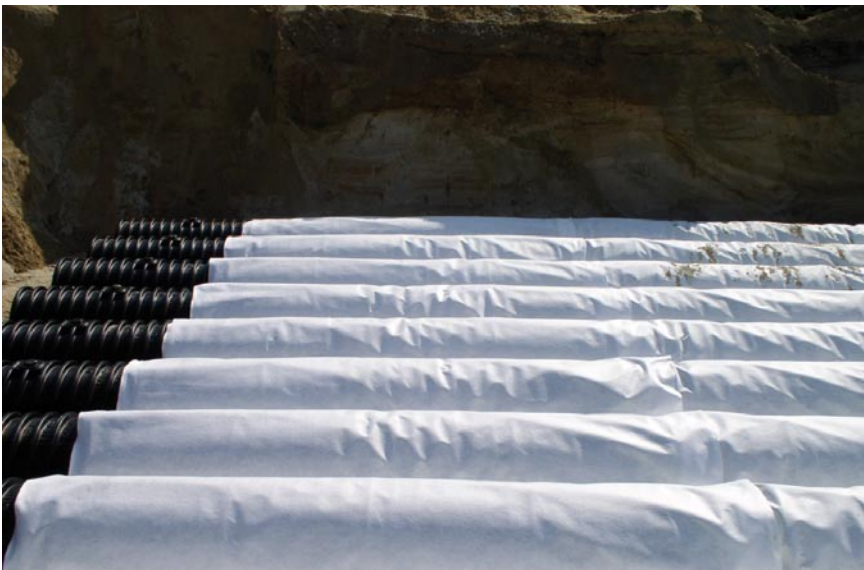
4 Tunnel mit Geotextil
