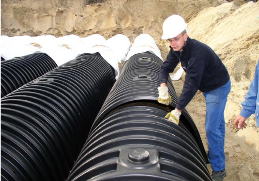
3 Das Verbinden der Elemente erfolgt durch einfaches Übereinanderhaken der ersten Rippe. Den Anfang und das Ende jeder Reihe bilden Start- bzw. Endkalotten
