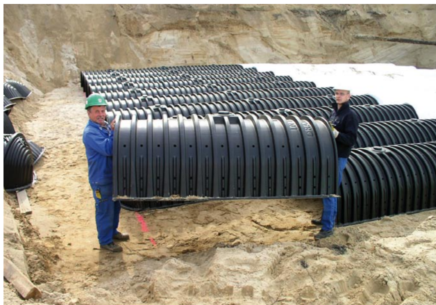
1 Thermalbad Ludwigsfelde – für die Versickerung des anfallenden Regenwassers kamen insgesamt 120 Tunnelelemente Drain-Max zum Einsatz - verteilt auf zwei Rigolenfelder - also ein Nettovolumen von 192 m 3 mit einer Erdüberdeckung von 1,75 m
